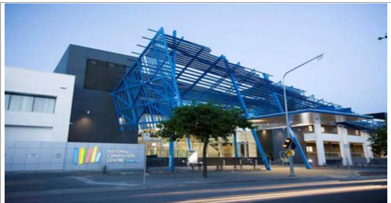
[그림 8] 호주 캔버라국립컨벤션센터(National Convention Centre Canberra, NCCC)
